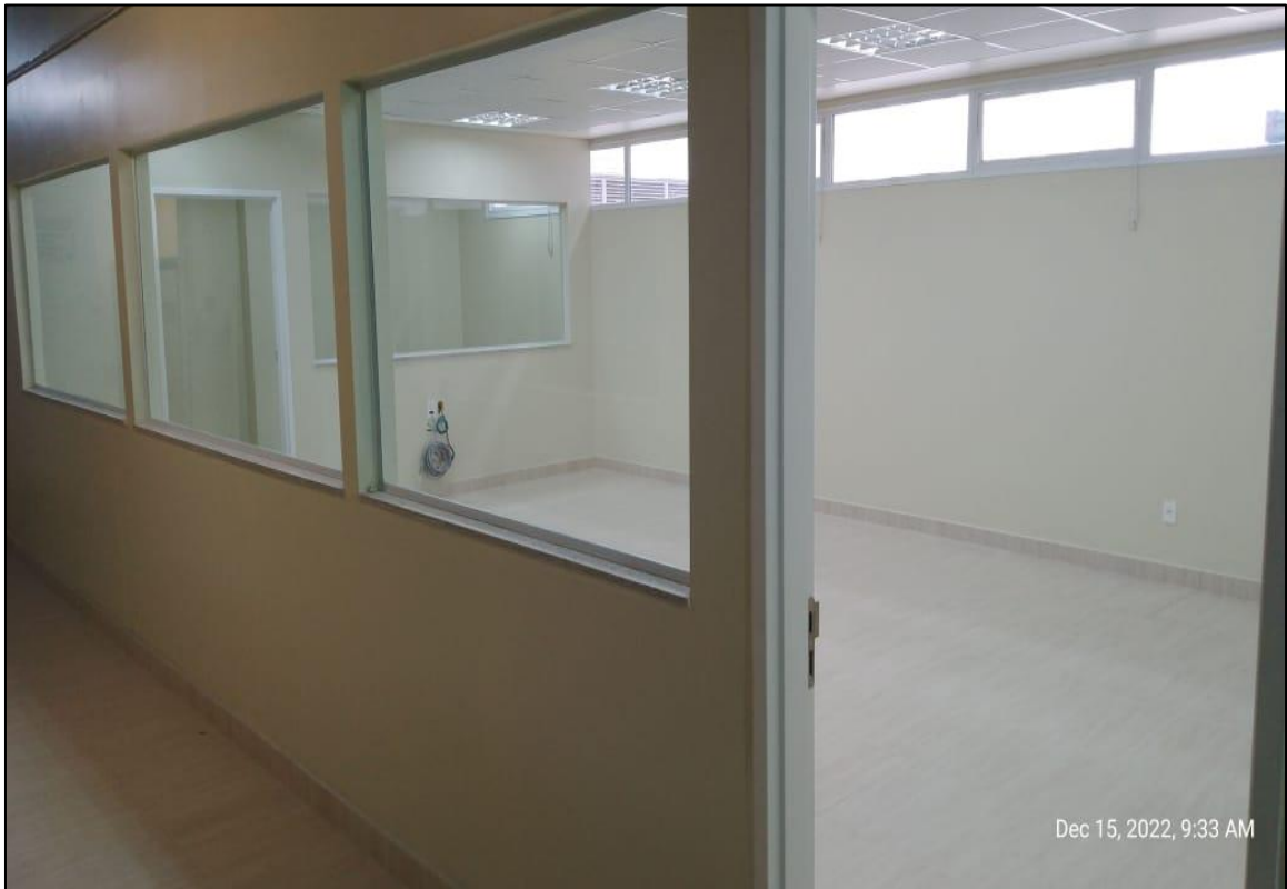
ENGENHARIA DE MANUTENÇÃO
